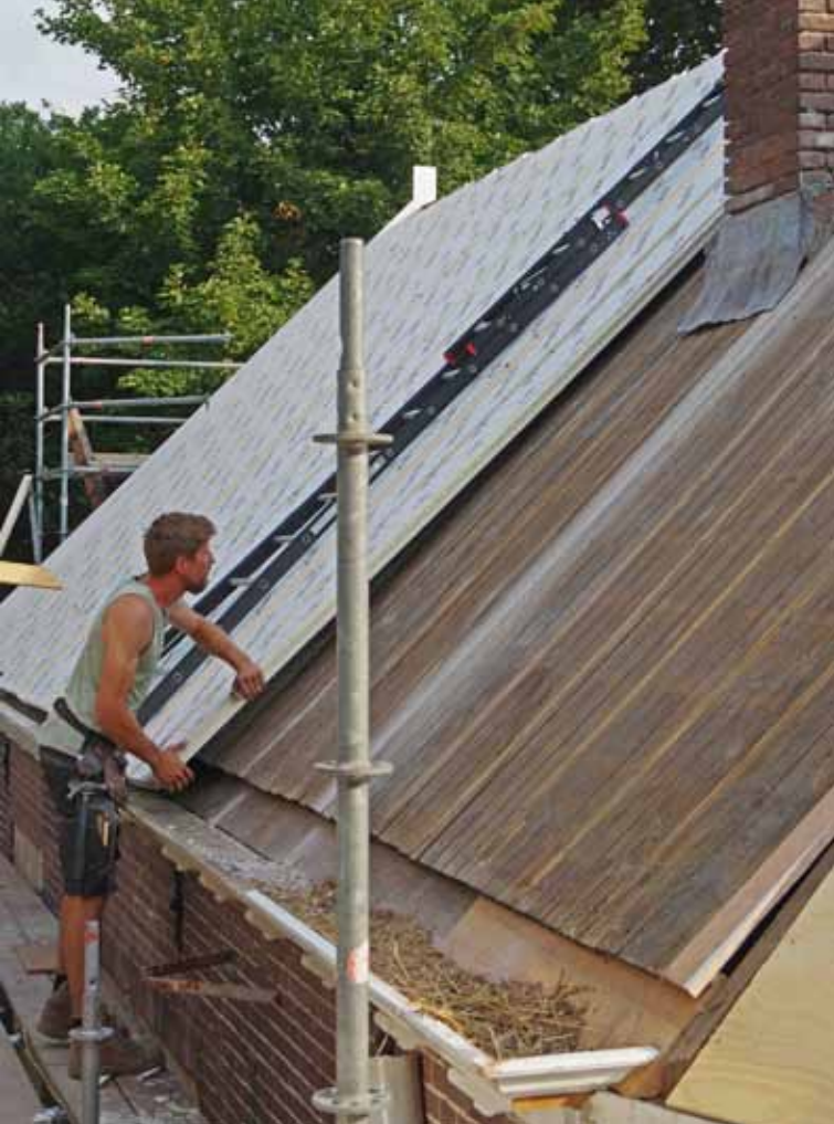
^ Opbouw van het dak met een extra isolatiepakket van 40 mm. De windveren aan de voorzijde werden aangepast aan het opgehoogde pakket (Theehuis Hoekelum, Bennekom)
