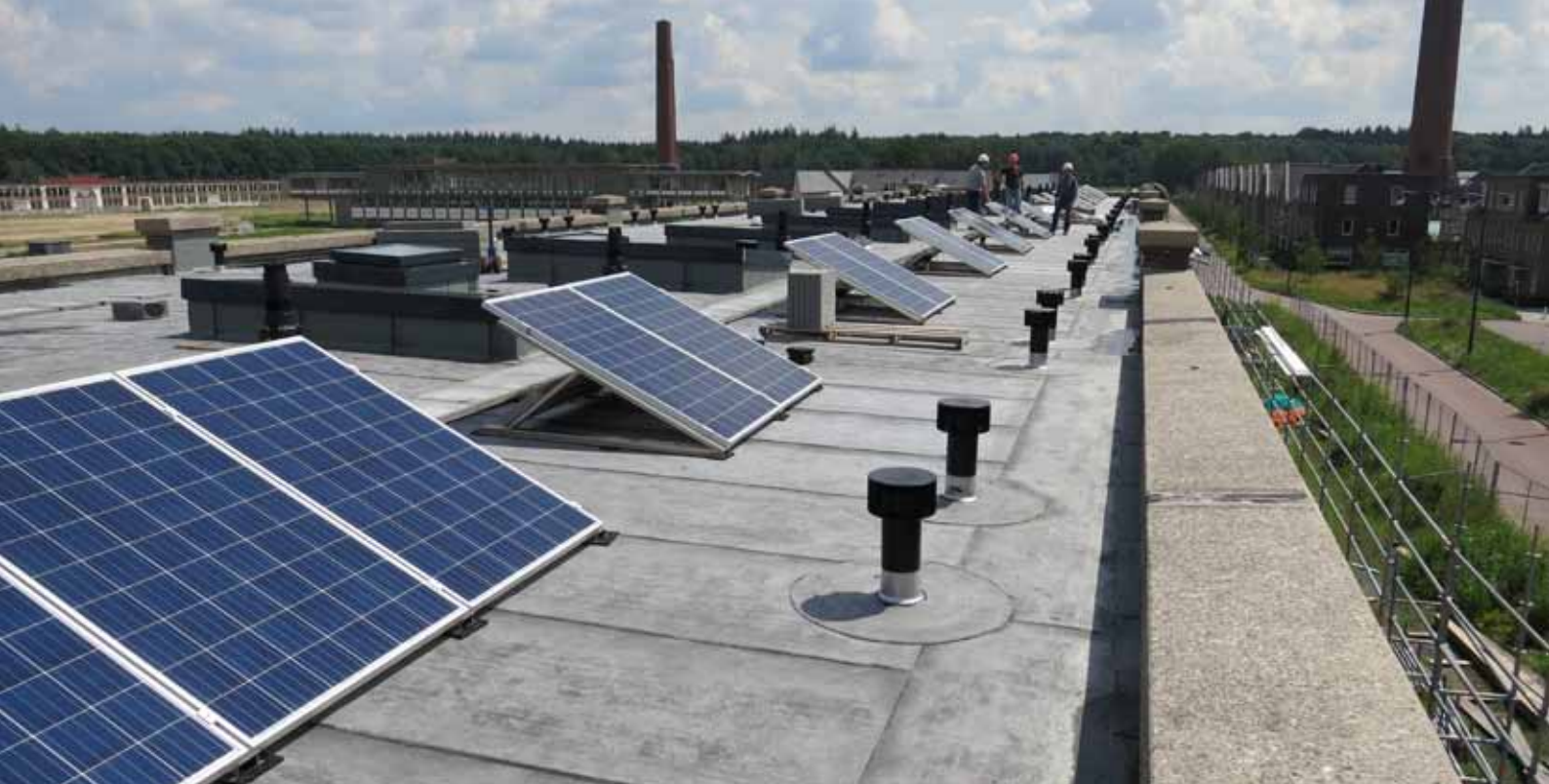
^ Panelen uit het zicht van de openbare ruimte (achter de dakrand van de voormalige bitterzoutloods Enka, Ede).
