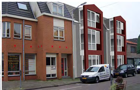
Appartementen aan de Bospoort te Ede.
