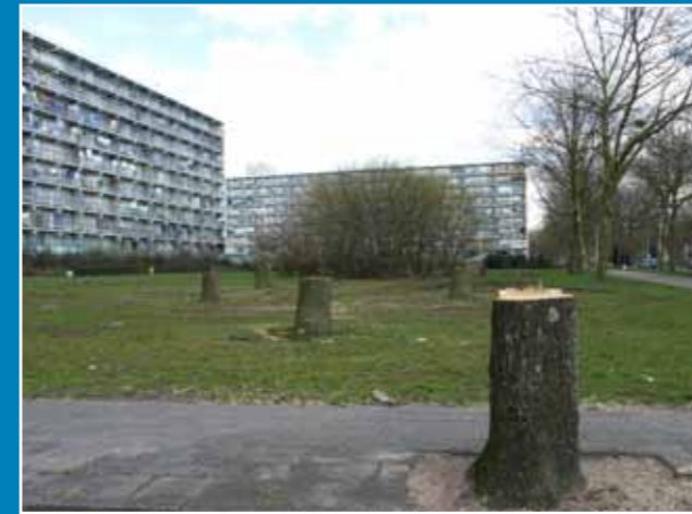
De eerste tekenen van de start van de vernieuwing van de wijk Veldhuizen-A zijn zichtbaar.
