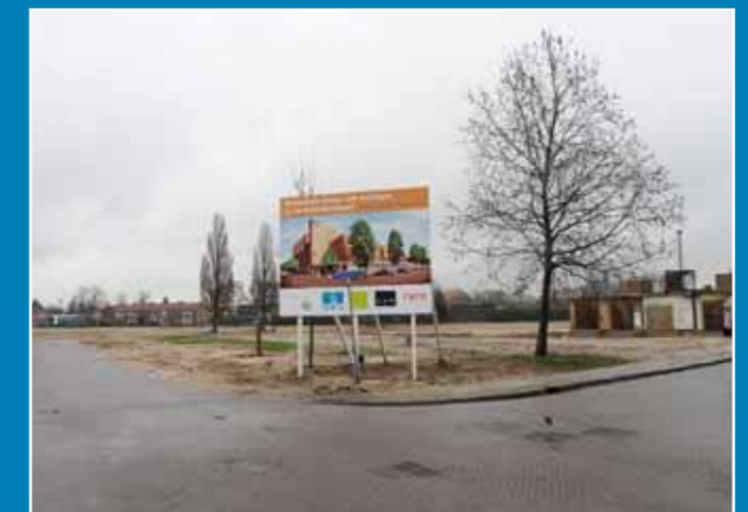
In de Uitvindersbuurt in Ede Zuid zien we op deze foto na de sloop van woningen nog een zandvlakte. Het bord kondigt de bouw van 450 woningen echter al aan.
