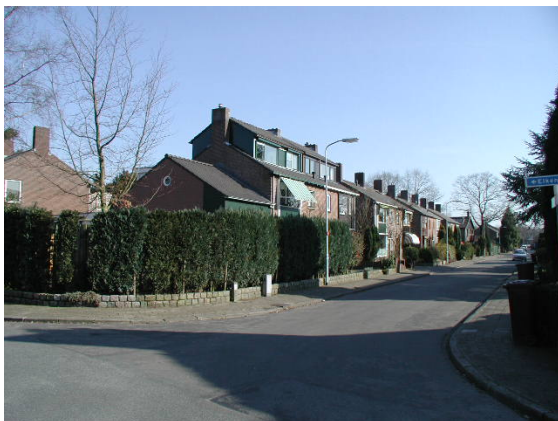
Dakopbouw op particulier initiatief aan de Margrietlaan.
