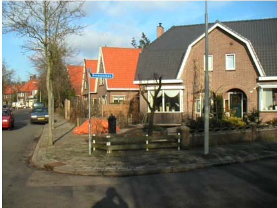
Op de voorgrond oudere woningen met mansardekap, verder in de straat planmatige invullingen met zadeldak (Nassaulaan).
