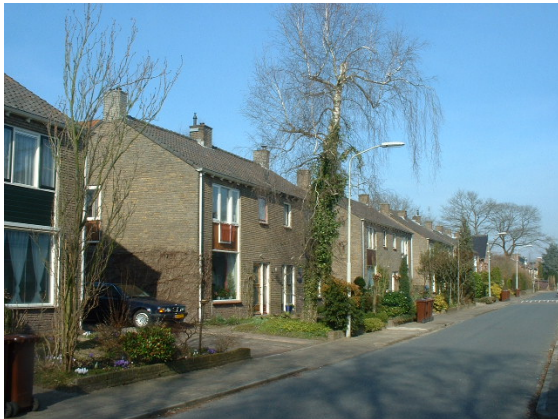
Naoorlogse, planmatige uitbreidingen aan de Margrietlaan.
