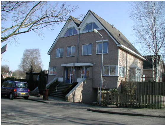
Nieuwbouw aan de Heidelaan.
