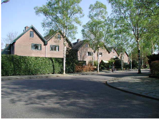
Woningen aan de Breehoven. Een regelmatig verspringende rooilijn.
