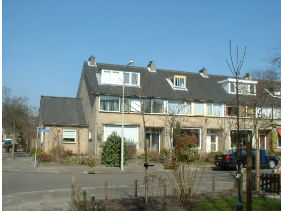
Verschillen in grootte en kleurgebruik van de dakkapellen aan de Kortehoven.
