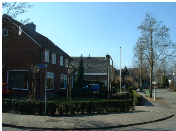
Profiel van de Brinkerweg.
