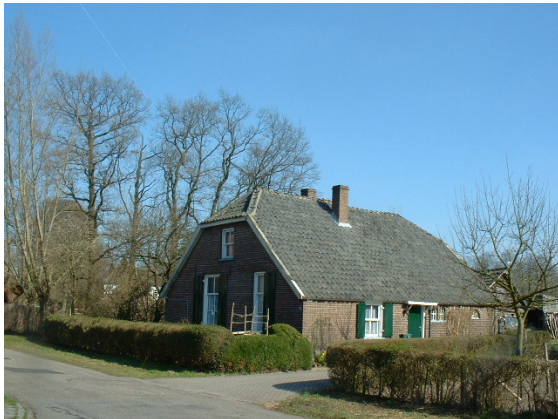
Boerderij aan de Halderbrinkweg als herinnering aan oorspronkelijke functie van het gebied.
