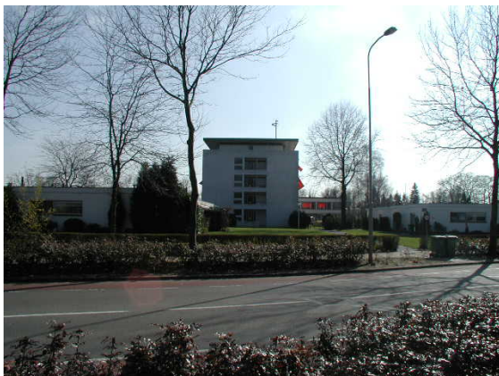
Eén van de twee bejaardencomplexen in het deelgebied op de hoek Commandeursweg-Van Balverenweg.
