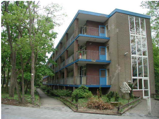
Etagebouw langs de Juliana van Stolberglaan.
