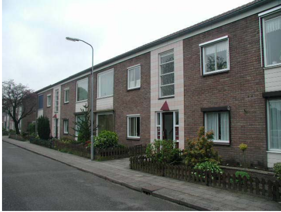
Portiekwoningen langs de Ganzeweide.
