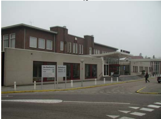
De nieuwgebouwde entree van het congrescentrum gezien vanaf de Bennekomseweg. Het donkere gebouw is het oorspronkelijke ontspanningscentrum voor ENKA-medewerkers.
