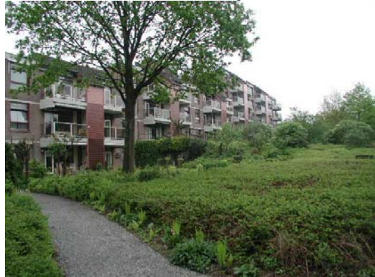
Etagewoningen langs de Molenstraat. Het verschil in hoogte is goed te zien.
