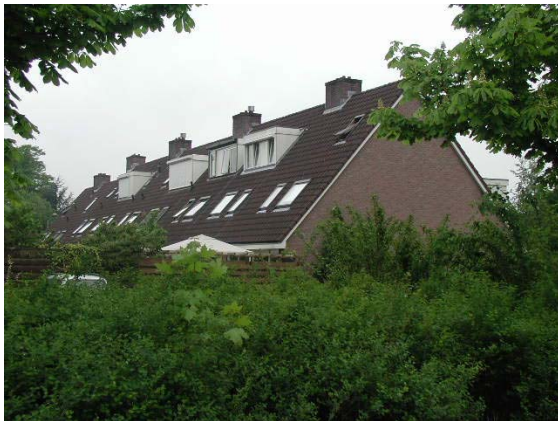
Verschillende dakkapellen op de achterkant van de woningen aangebracht. Hier aan de Bunschoterweg.
