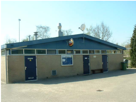
Kantinegebouw en kleedkamers van de voetbalvereniging.
