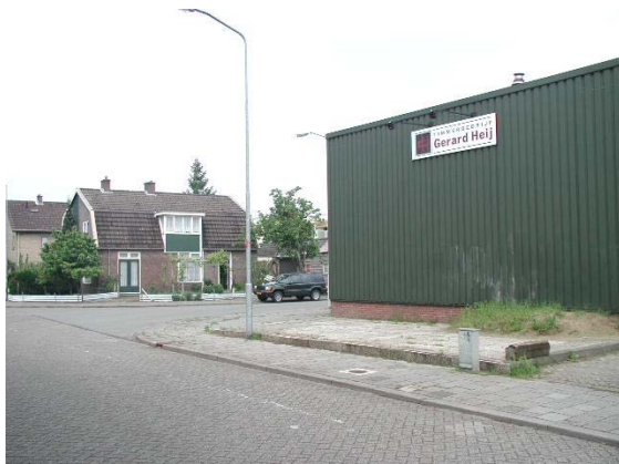
Vanaf de Noordelijke Parallelweg (en het spoor) kijkt men tegen een blinde muur aan. Op de achtergrond enkele woningen.
