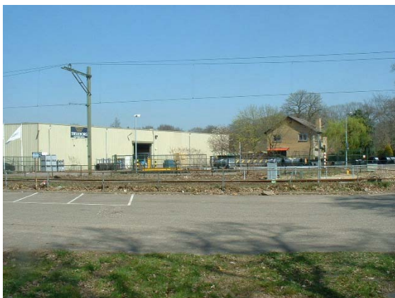
Bedrijfspannd en –woning in sobere kleurstellingen aan de Knuttelweg.
