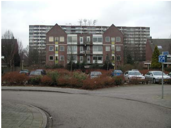
Hogere woningbouw aan de Ferdinand Bolstraat. Op de achtergrond flats aan de Jan Th. Tooroplaan.
