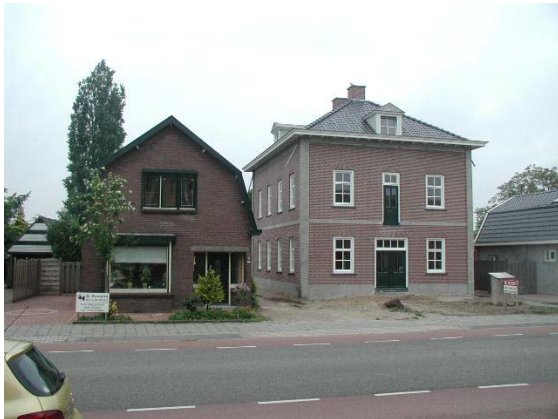
Het rechter gebouw is vervangende nieuwbouw aan de Veenderweg. Qua stijl passend. Bouwhoogte, plaatsing op de kavel en parcellering wijken echter sterk af van het straatbeeld.
