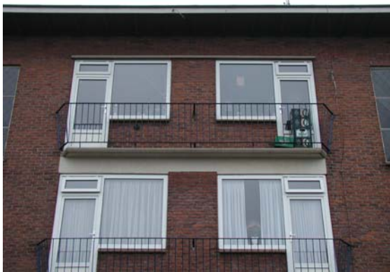
Toepassing van bescheiden geveluitbouw geeft een beter straatbeeld. De gebruikswaarde is echter beperkt.
