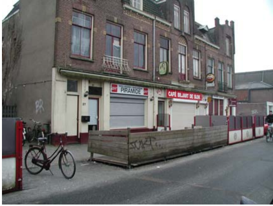
Geen eenheid tussen bouwlagen en 'terrassen' op de openbare weg geven een verloederd straatbeeld.
