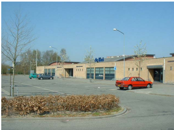
Verzamelgebouw tegenover het zwembad aan de Peppelensteeg.
