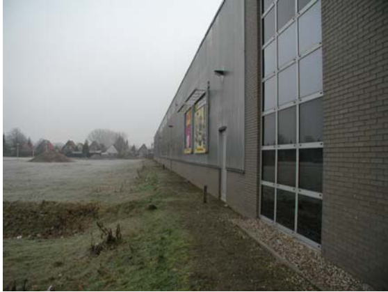
Onderkant van de gevel opgebouwd uit bakstenen.
