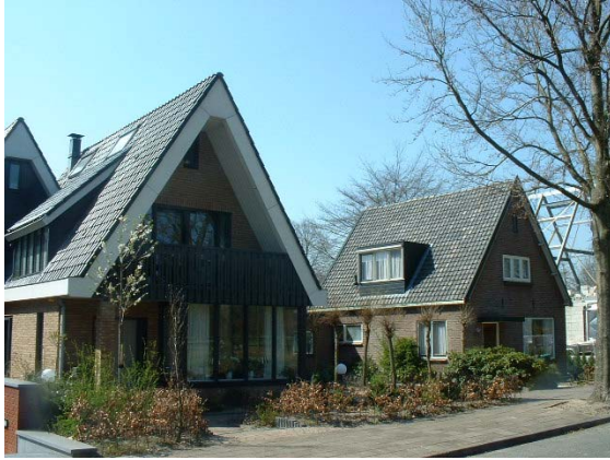
Nieuwbouw in dezelfde stijl als bestaand bebouwingsbeeld van de Slijkruikweg. De overstek is vrij fors aangezet.
