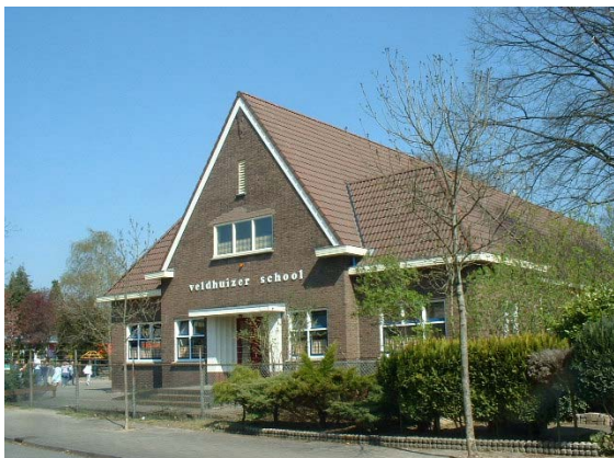
Het gebouw van de Veldhuizer school.
