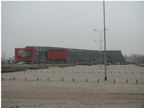
De Cinamec. Een grote bouwmassa op een zichtlocatie langs de snelweg A12.
