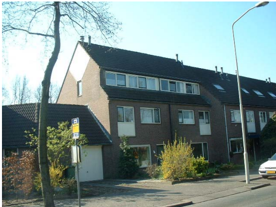
Typische woningbouw uit de tweede helft van de jaren zeventig.
