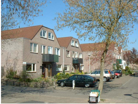
Onderdeel van bebouwing in een woonerf aan de Klingelbeek.
