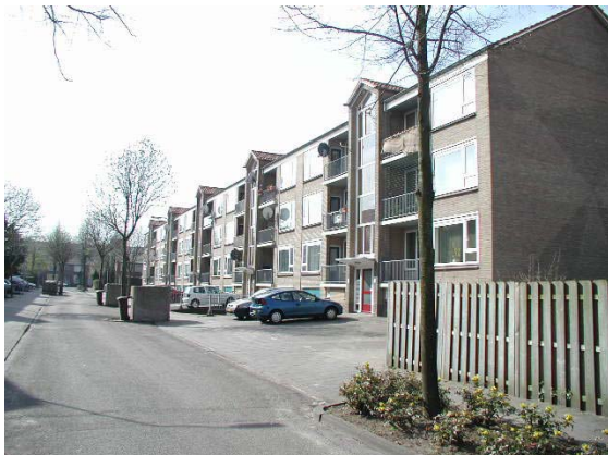
Etagewoningen aan de Stephensonstraat met fraaie portieken die de ingangen accentueren.
