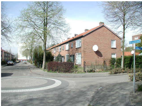
Schotel op zijgevel van hoekwoningen aan de Edisonstraat is niet bevorderend voor het bebouwingsbeeld.
