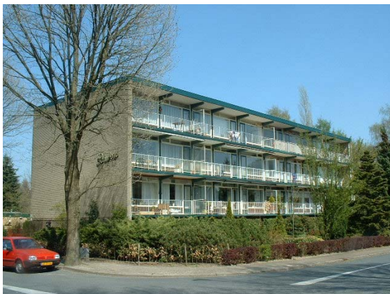
Etagewoningen langs de Schäferlaan in een modernistische stijl.
