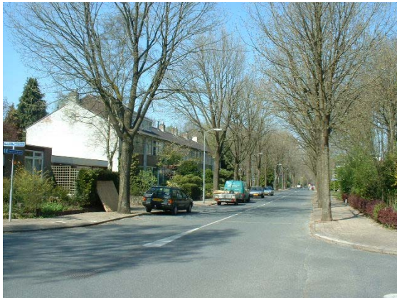
Het profiel van de Sweelincklaan.
