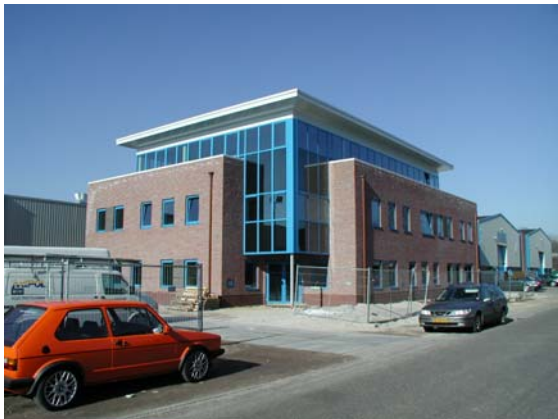
Nieuwbouw langs de Molenweg. De representatieve gevel staat aan de weg en de ingang is duidelijk gemarkeerd..
