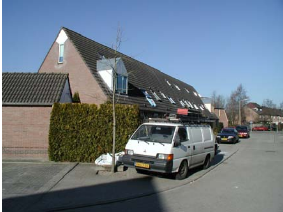
Dakramen zijn onregelmatig op het dakvlak geplaatst. Hoekwoningen zijn voorzien van dakkapellen. Hier aan de Ruttenbeeklaan.
