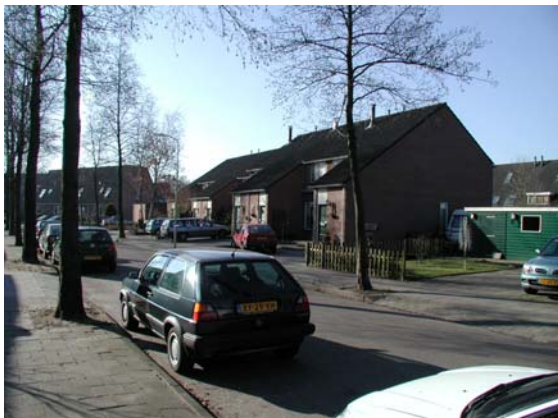
Uitbouwen in ontwerp opgenomen geven de Ruttenbeeklaan een rustig karakter.
