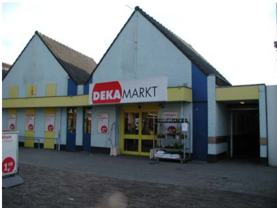
Afwijkende bebouwing ten opzichte van het historisch Dorpslint van de Dorpsstraat.
