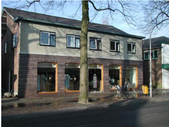
Door de toepassing van aparte gevelopeningen wordt de schaal verkleind.
