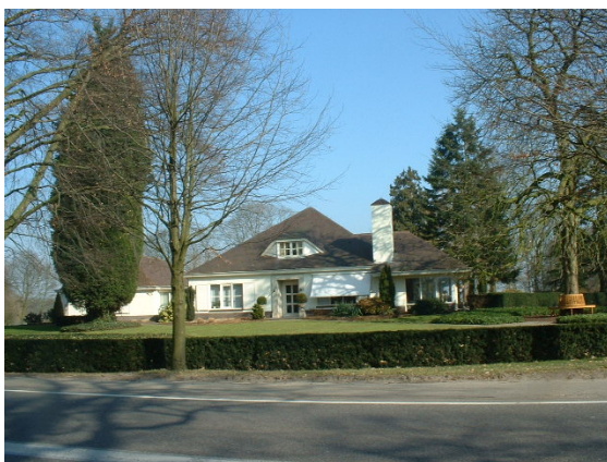
Eigentijdse invulling met een samengestelde kap nabij entree van Lunteren, aan de Dorpsstraat.
