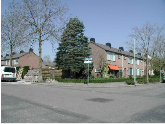
Ruime opzet van het stratenpatroon met daarbinnen een helder patroon van bouwblokken.
