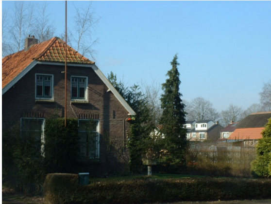
Dakkapellen zijn her en der aangebracht. Woningen aan Groen van Prinstererstraat, gefotografeerd vanaf de Postweg.
