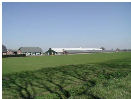
Grote ligboxen in het kampenlandschap nabij Lunteren. Een voorbeeld van (te) forse dakvlakken.
