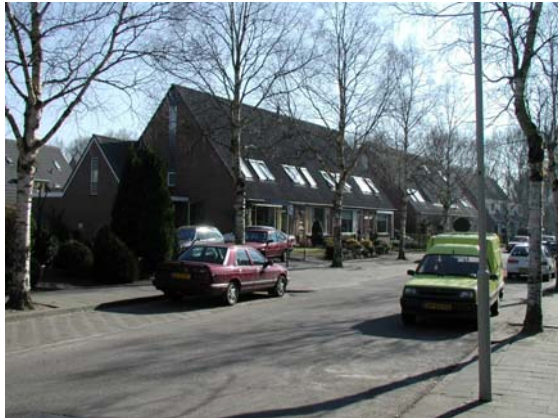
Rijteswoningen gelegen in een rooilijn aan De Dries. Scherpe scheiding tussen openbare en privé ruimte.
