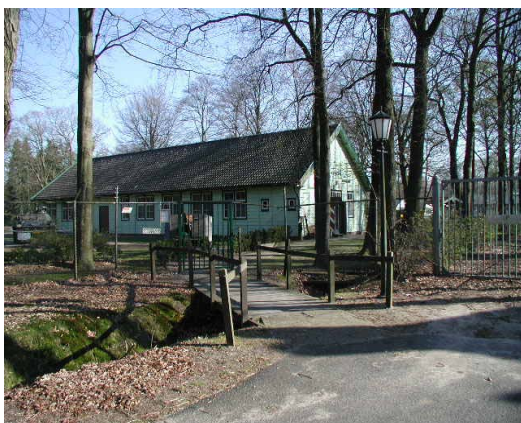
Historische houten bebouwing op de Legerplaats Harskamp
