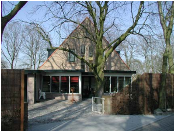
Recente uitbreiding van een karakteristieke woningen aan de Molenparkweg.
