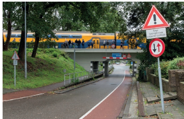
Onderdoorgang station Veenendaal-De Klomp (bron: gemeente Ede)
