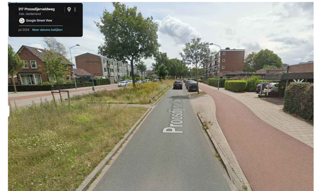
Bestaande situatie, locatie maatregel Proosdijerveldweg-noord Bron: google maps
