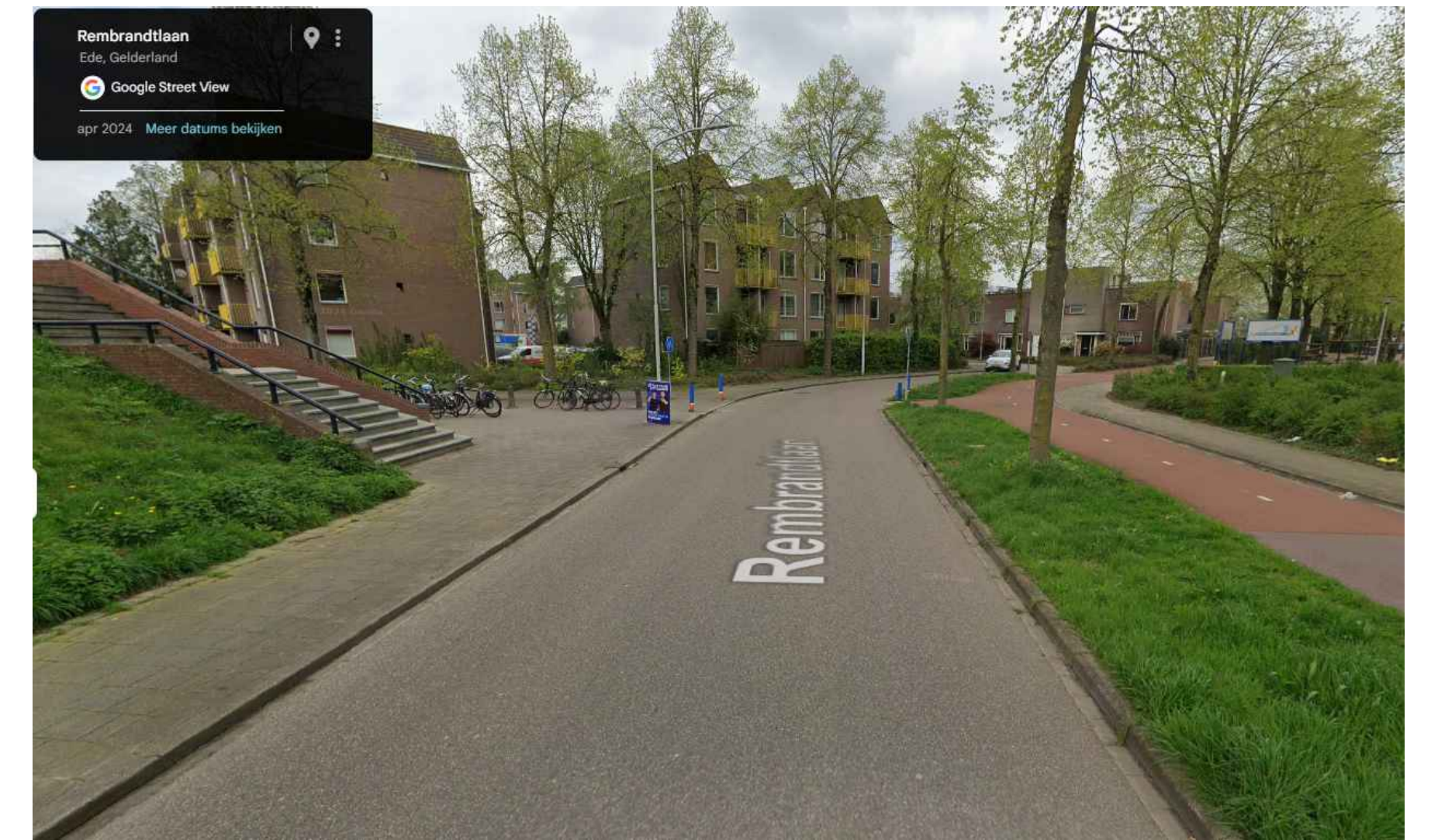
Bestaande situatie, locatie maatregel Rembrandtlaan
