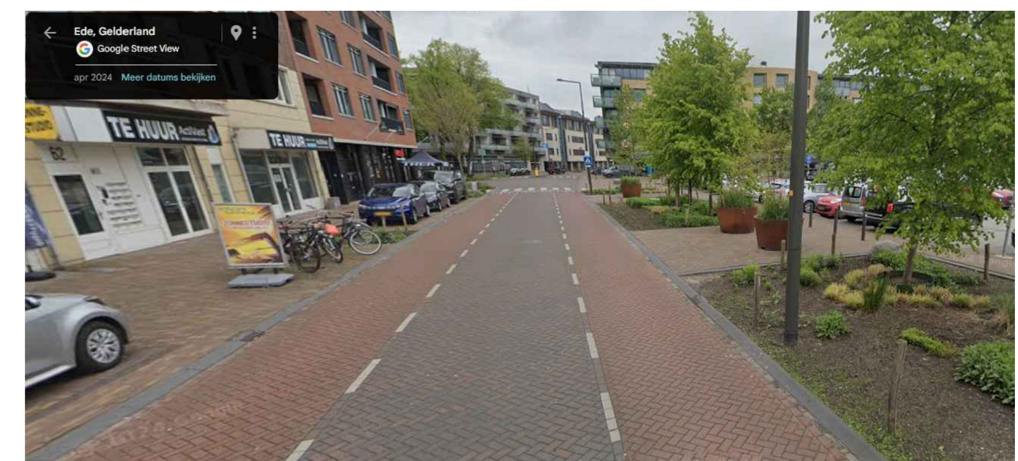
Bestaande situatie, locatie maatregel Telefoonweg zuid Bron: google maps
