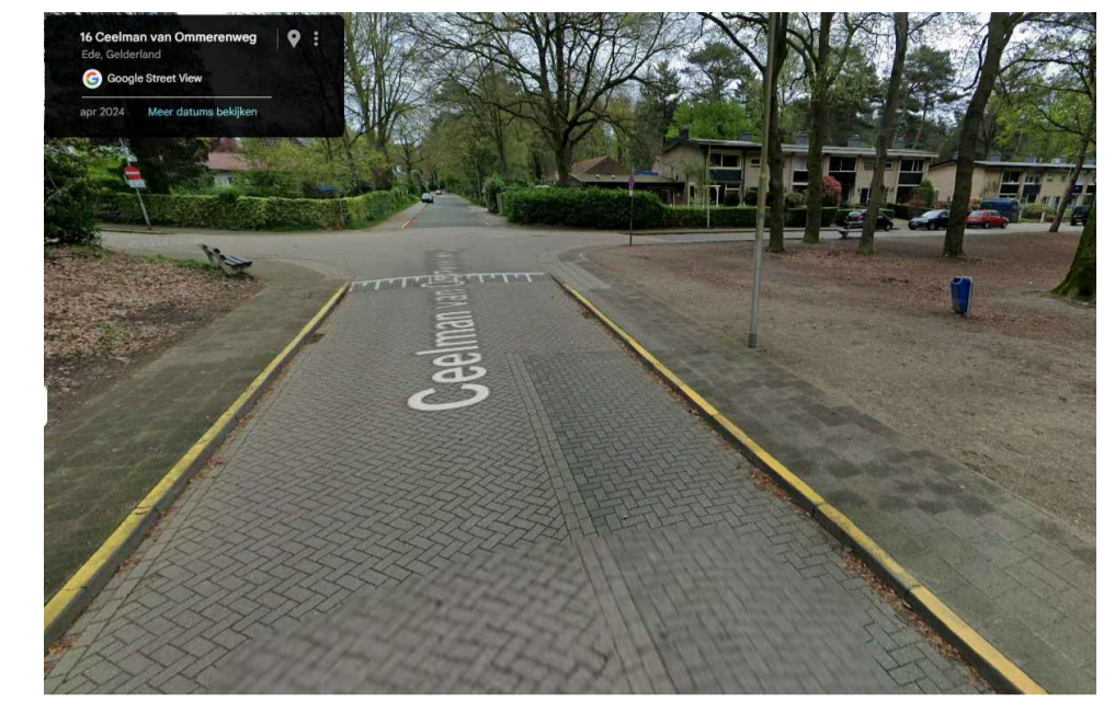
Bestaande situatie, locatie maatregel C. van Ommerenweg zuid Bron: google maps
